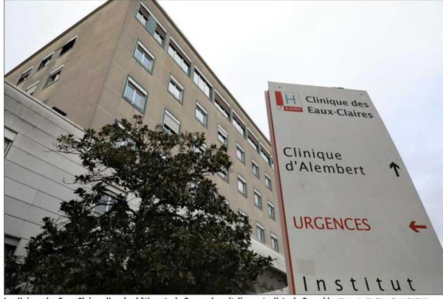
La clinique des Eaux-Clares, l'un des bâtiments du Groupe hospitalier mutualiste de Grenoble. Photo Le DL/Benoît LAGNEUX
